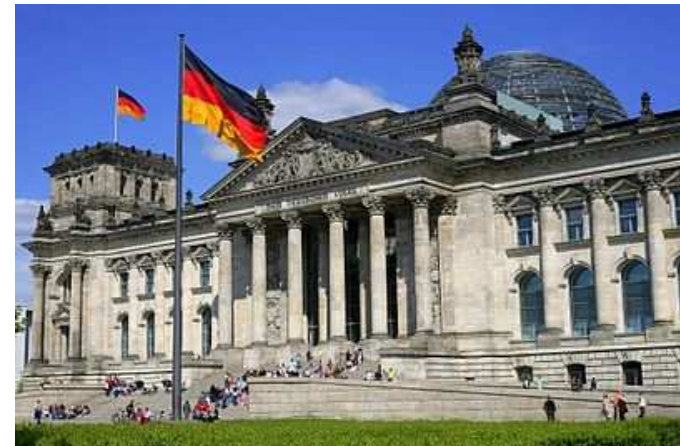
Le Reichstag à Berlin est chauffé et refroidi par deux aquifères, c'est-à-dire deux ATES
